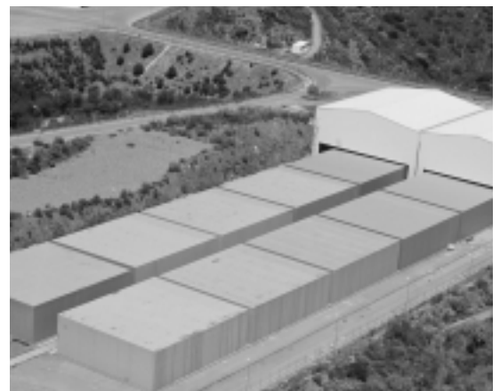
Vista aérea plataforma norte de El Cabril.
