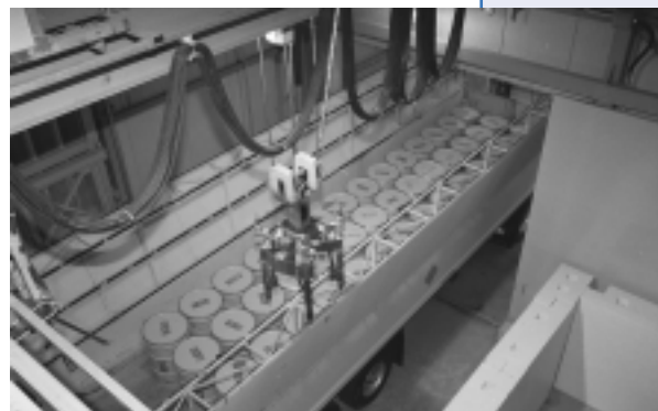
Descarga de RBMA de un camión.
